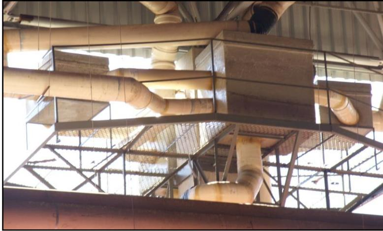
Figura 2 Caixas de “Pré-decantação” e suas derivações
