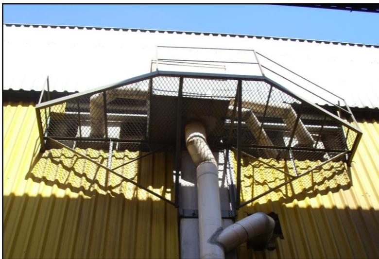
Figura 3 Caixa Pré-decantadora e seu acesso para a limpeza
