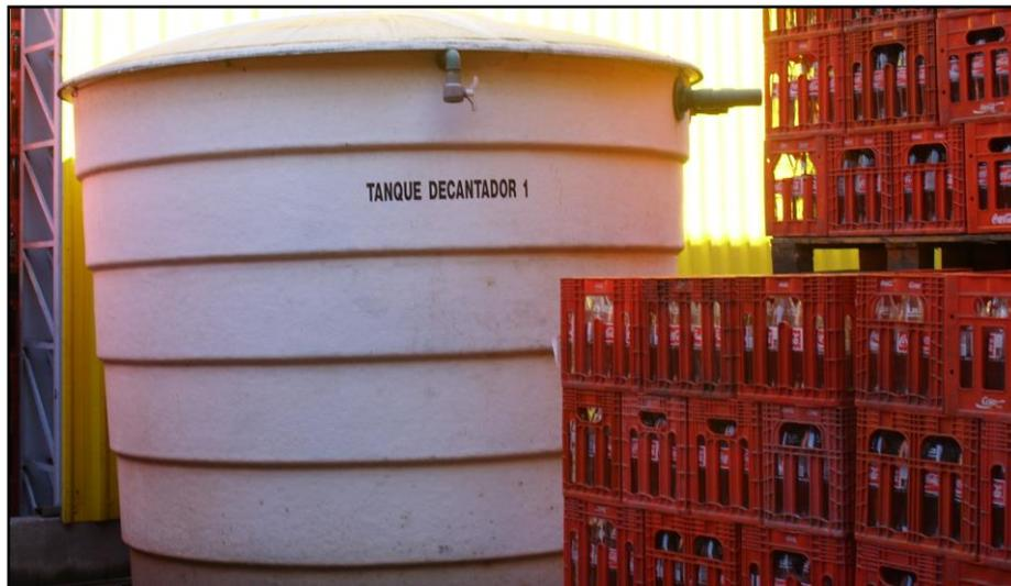
Figura 4 Tanque Decantador
